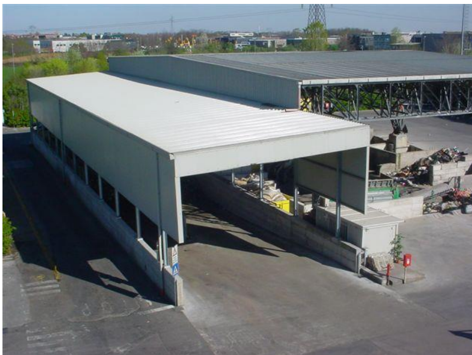
Fig. 5 : Stazione di trasferimento di Bellusco-Mezzago
